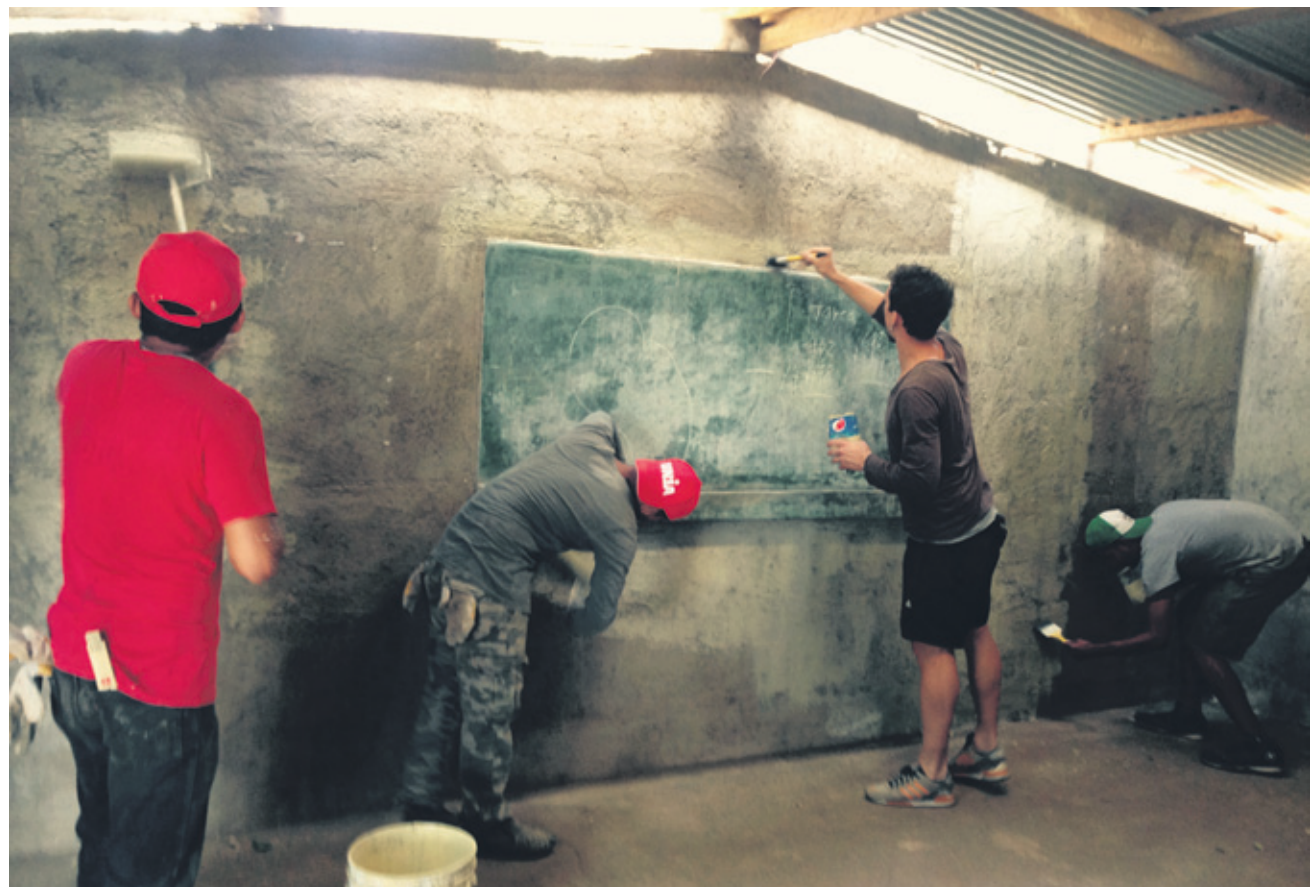
Les jeunes de la région biennoise ont travaillé avec des artisans locaux. Ici, la réfection des murs.
